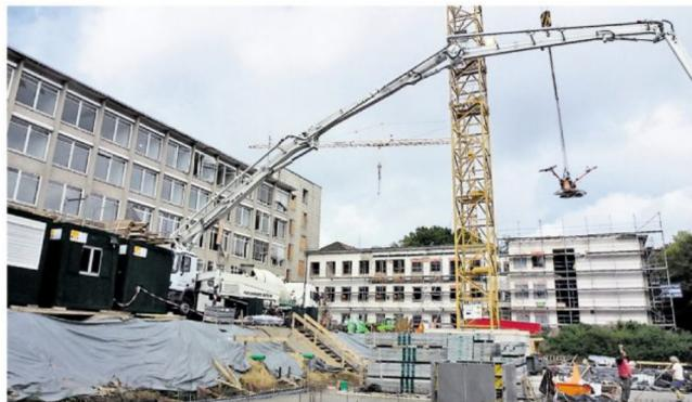
Der Altbau (l.) wird umgebaut, vorne wird die Betonplatte für die Neubauten gegossen. *Der Altbau (l.) wird umgebaut, vorne wird die Betonplatte für die Neubauten gegossen.*
