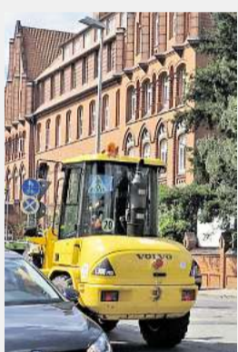
Die ersten Bagger sind am Gelände in Limmer angekommen. Triller
